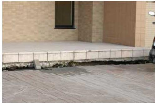
写真 2-3-2 液状化による建物と地盤の段差の発生（出典：浦安震災アーカイブ）
