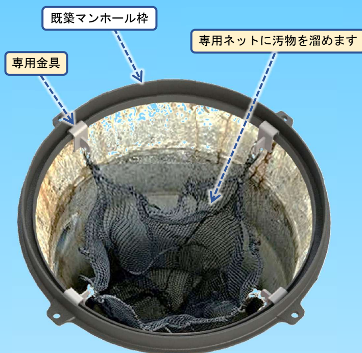
汚物捕捉ネットを設置した状態
